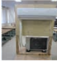
冷媒配管の施工と空調機器据付け技術
