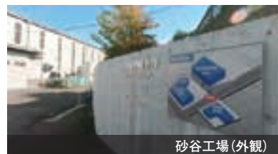
砂谷工場(外観)
