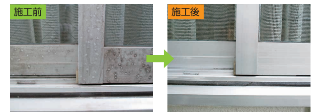
経年劣化によるチョーキング(退色)したアルミサッシと復元後
