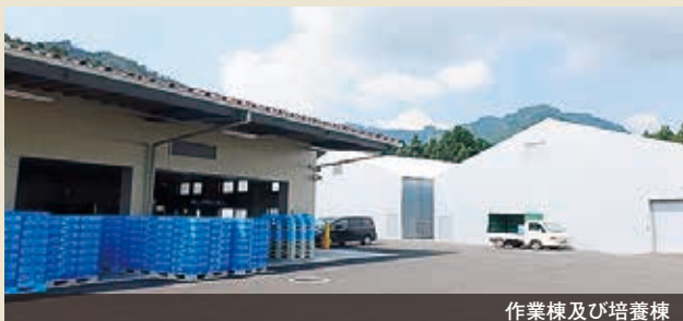
作業棟及び培養棟
