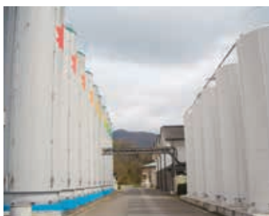
屋外発酵タンク
